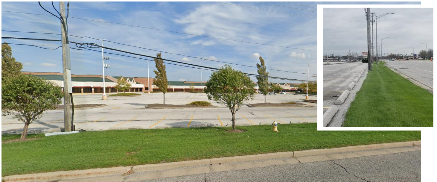
HARLEM AVENUE FRONTAGE
